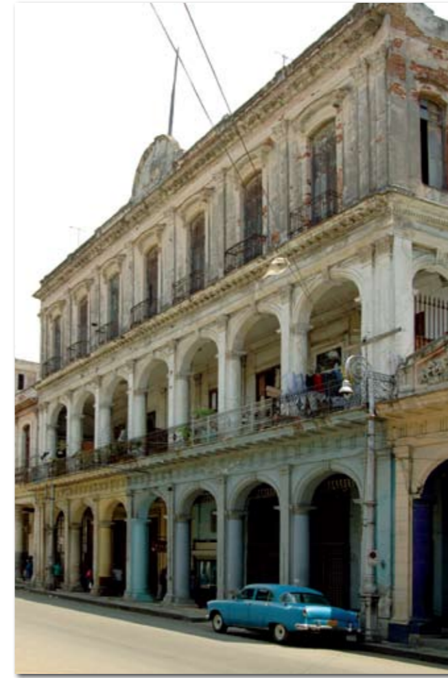
Die Manufaktur des Francisco E. Fonseca auf der Calle Galiano 466. Die Straße ist nicht breit genug, als dass man weit genug weg stehen und das Gebäude in seiner vollen Größe erfassen kann.
