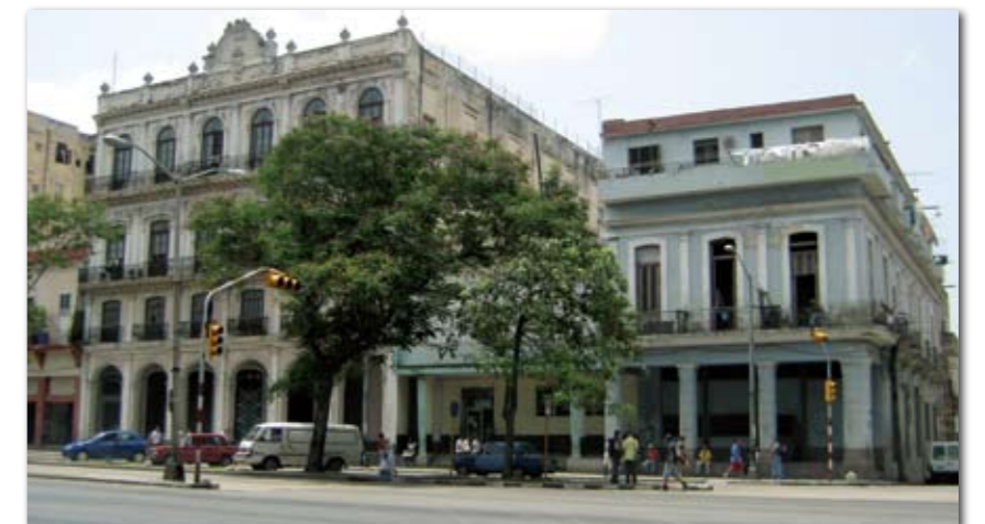
Der Gebäudeteil rechts im Bild könnte, vergleicht man dieses Gebäude mit dem auf dem historischen Foto, ein Teil der Manufaktur gewesen sein.
