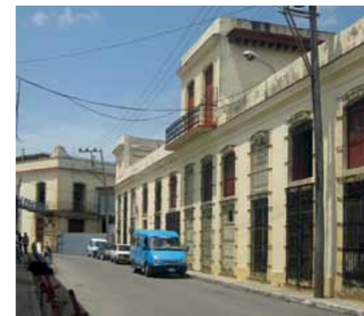
Die linke Seite des Gebäudes ist sehr gut mit der historischen Abbildung vergleichbar. Leider kann man das Gebäude aufgrund der engen Bebauung nicht im Ganzen fotografieren.
