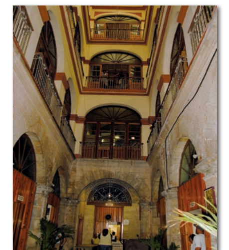
Der Innenhof des Gebäudes
