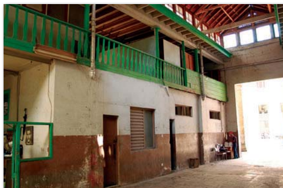
Die im Originalzustand erhaltenen Lagerräume mit der Möglichkeit zur Anlieferung entsprechen auch noch heutigen Anforderungen.
